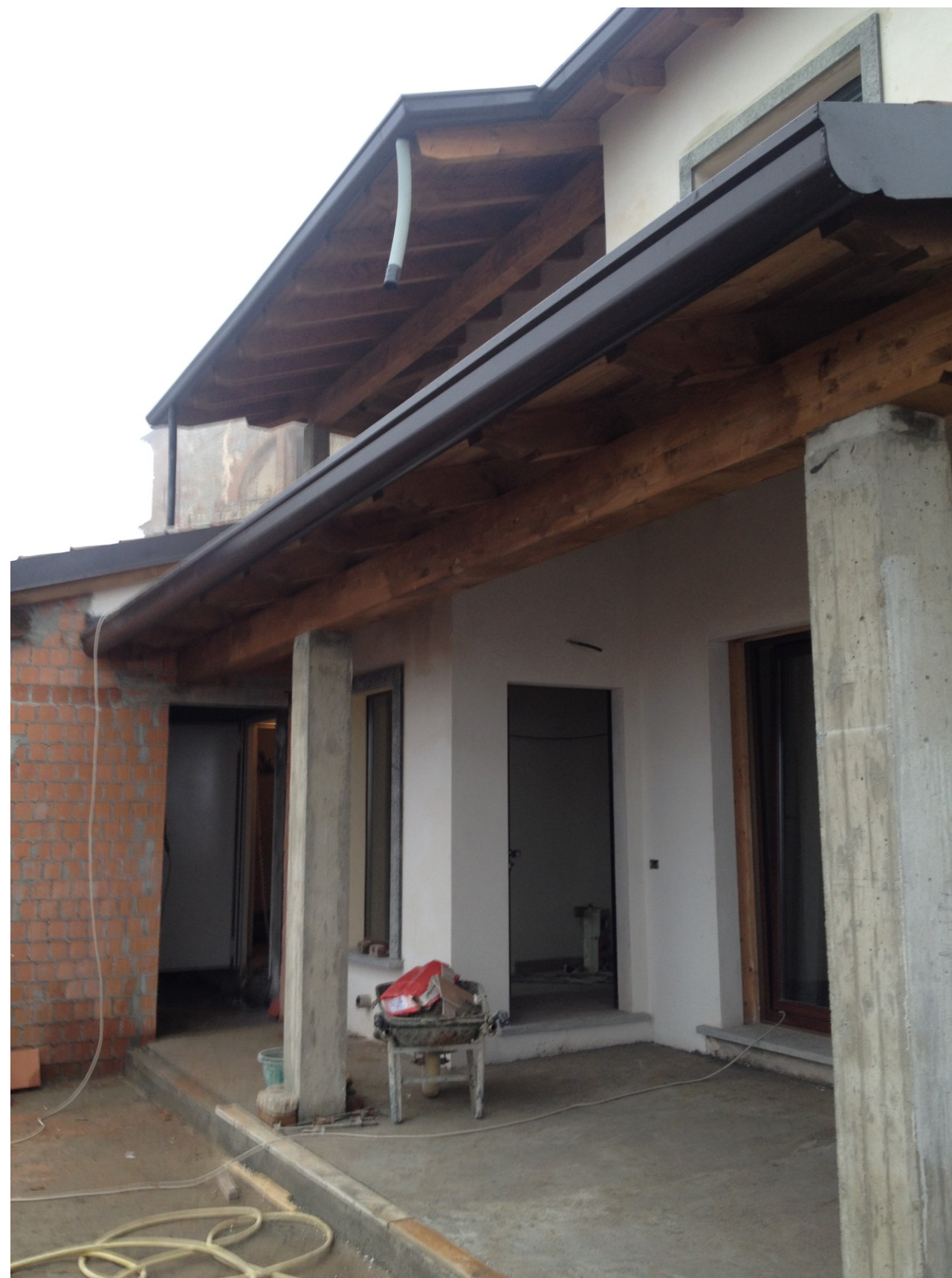
e durante la ristrutturazione
